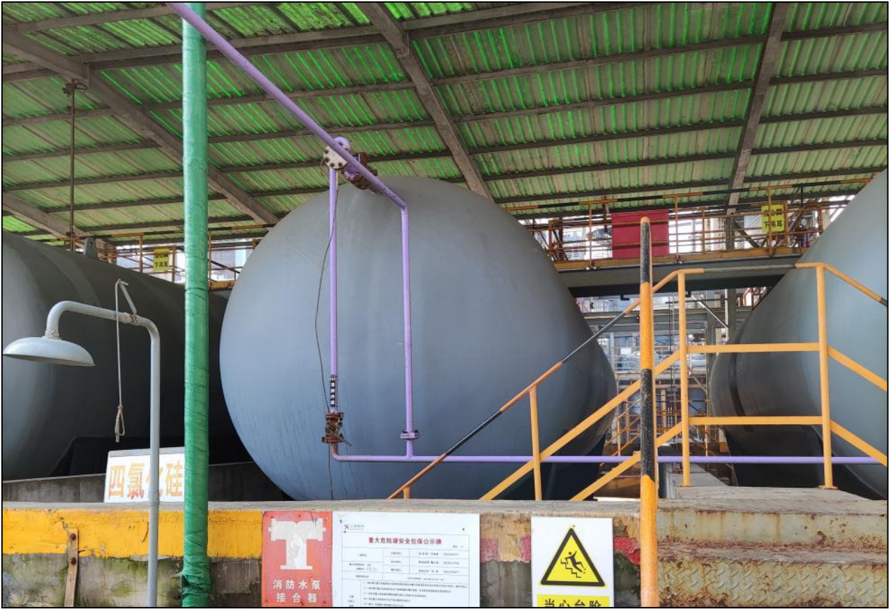
二期工程一个95m 3 三氯氢硅储罐更改为四氯化硅储罐
