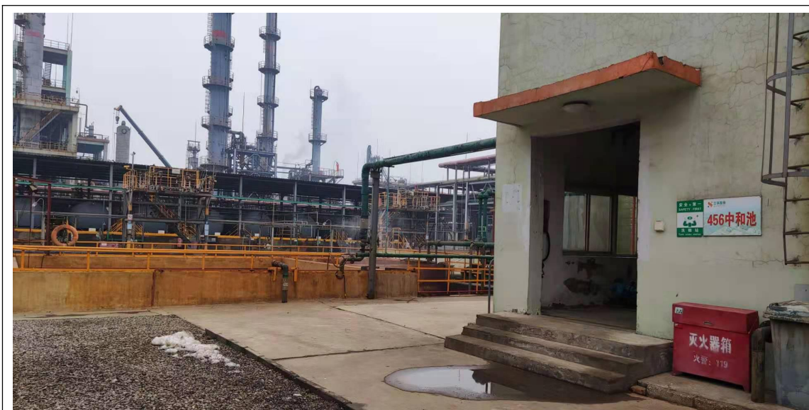
废水排入三孚硅业污水处理站，处理后排入市政管网
